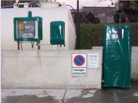
Wetterschutzhüllen für Tankstelle mit Sichtfenster und Reißverschluss
